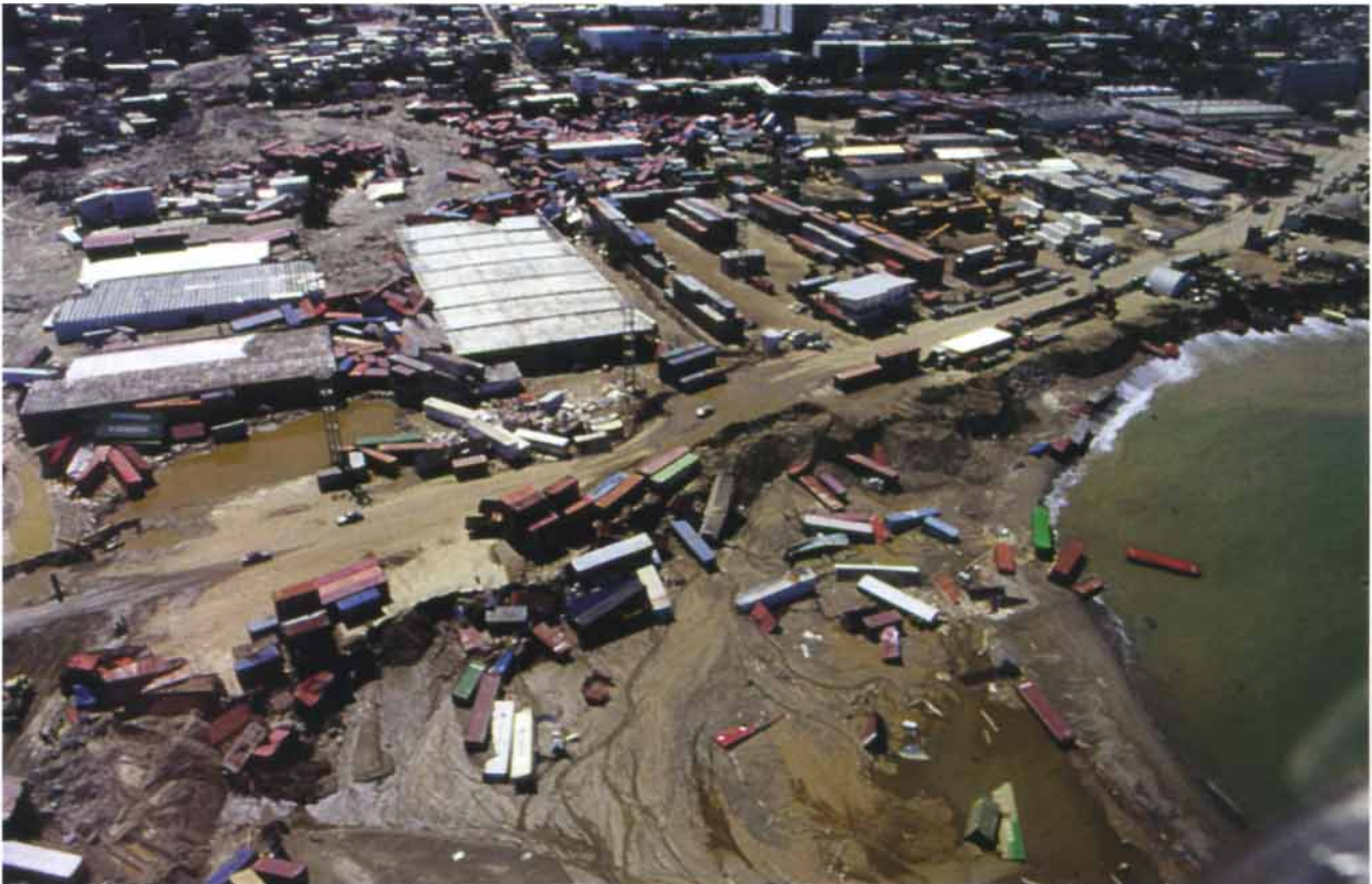
La Guaira - Puerto. Contenedores arrojados al agua. Tóxicos
