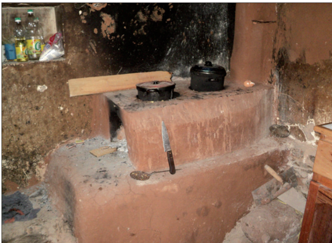
Foto 1. MVC: Cocina mejorada con chimenea - Urubambal.
