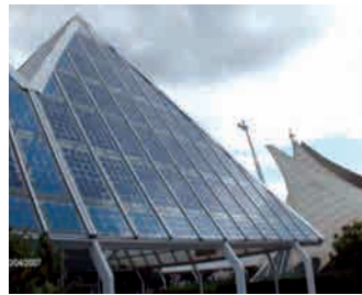
Figura 20. Instalaciones fotovoltaicas en el centro comercial: Madrid-2 La Vaguada. Fuente: elaboración propia.
