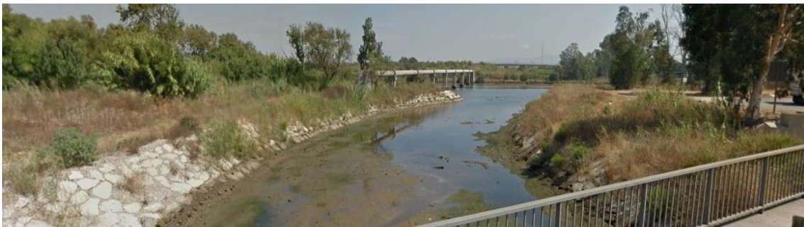
Ilustración 3: Confluencia entre el cauce y el Río Palmones (Fuente: google maps).
