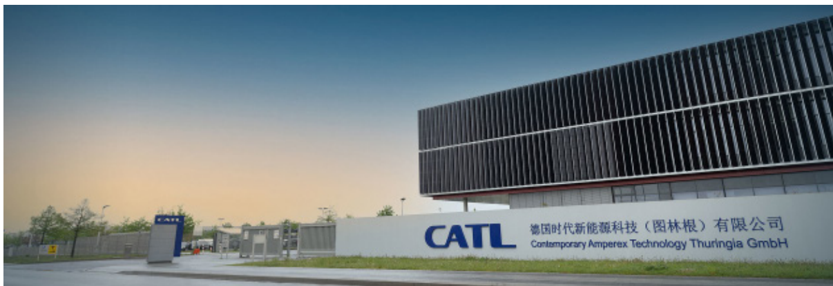
CATL: Empresa de fabricación de baterías china
