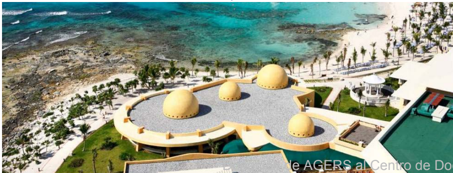
Detalle de cubiertas de la fase III de Maya
