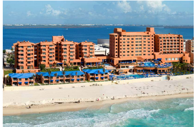
Barceló Tucancún tras la reconstrucción
