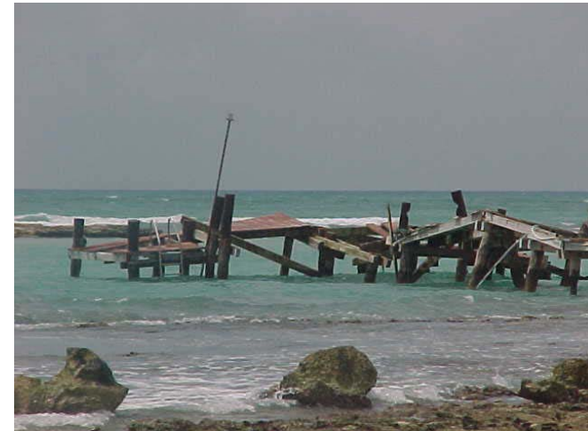
Muelle de Maya después paso del huracán Wilma
