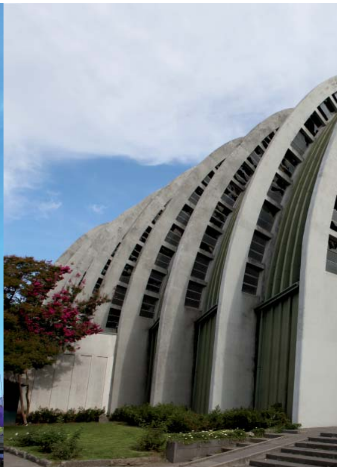
Catedral construida según norma sismoresistente. El único daño causado por el terremoto de 8,8 M del 27 de febrero de 2010 fueron ventanas rotas. Fuente: USGS.
