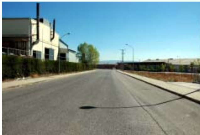
Aproximación a intersección, ausencia de marcas viales
