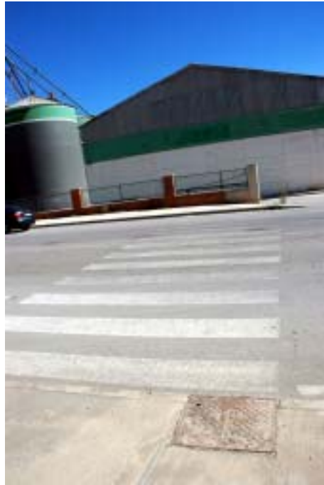
Paso de peatones sin señalizar
