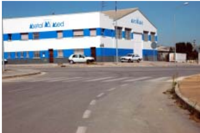
Paso de peatones sin señalizar
