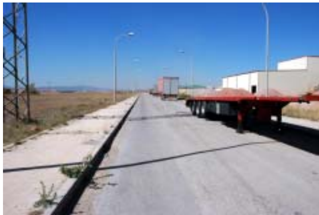
Camiones estacionados a un lado, sin señalizar
