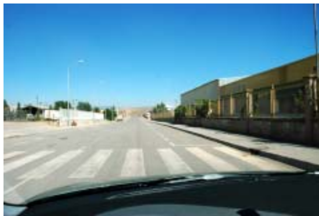
Paso de peatones sin señalizar
