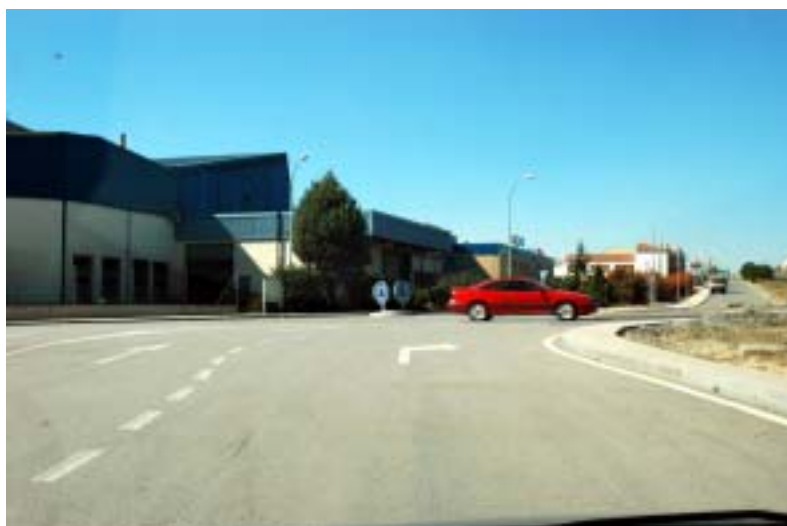
Ausencia de señalización vertical en intersección
