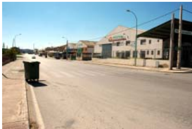
Paso de peatones sin señalizar
