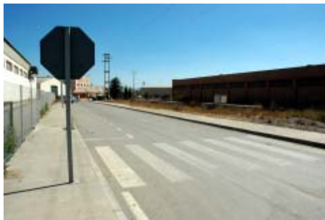
Paso de peatones sin señalizar
