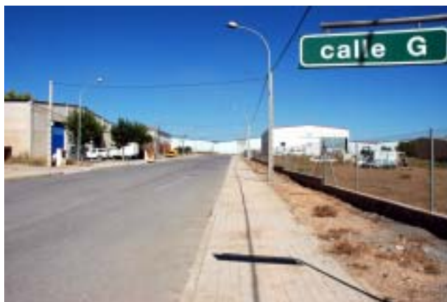
Desgaste de la señalización horizontal
