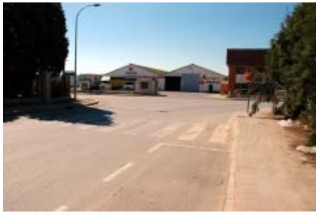
Paso de peatones sin señalizar
