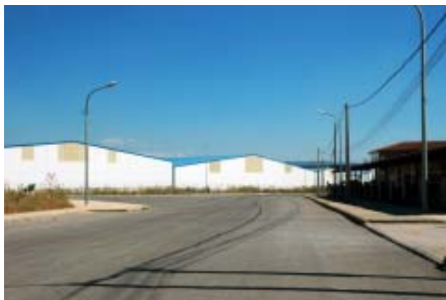
Intersección con calle L sin señalizar
