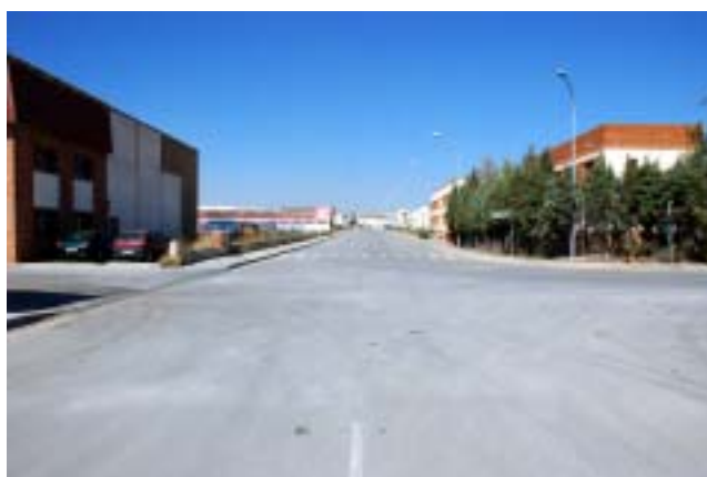
Ausencia de limitación de velocidad
