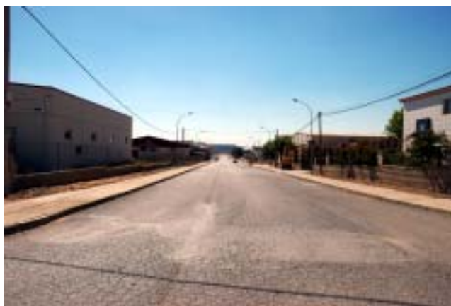
Vista contraria de calle G
