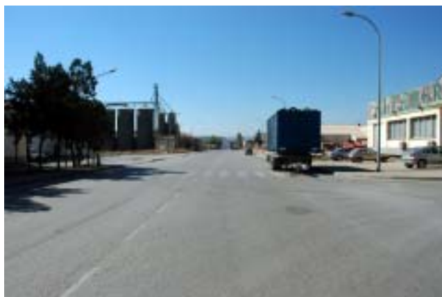
Paso de peatones sin señalizar
