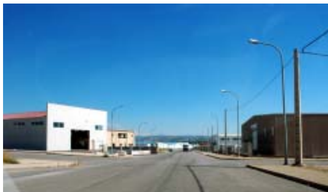
Intersección con calle LL sin señalizar
