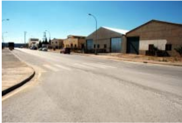
Paso de peatones sin señalizar
