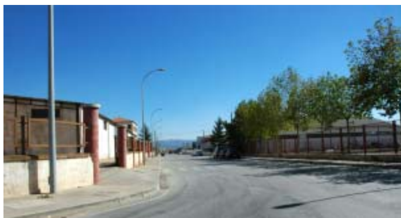
Paso de peatones sin señalizar
