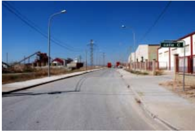
Ausencia de marcas viales
