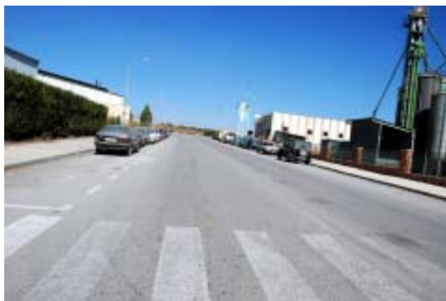
Tramo de calle F que interfecta con la calle A
