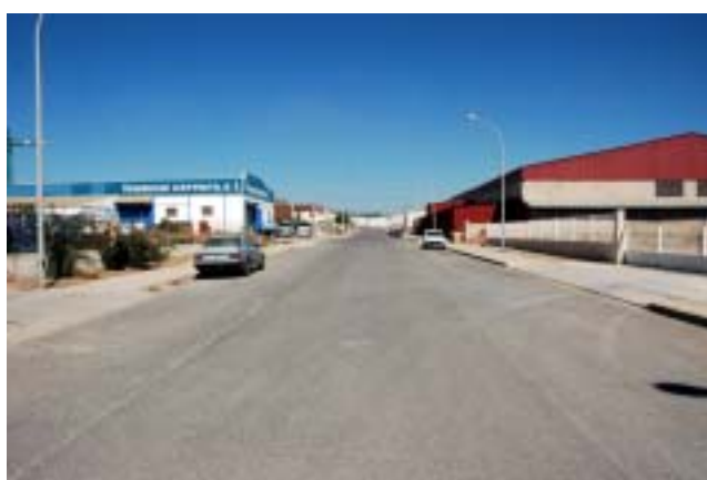
Ausencia de limitación de velocidad
