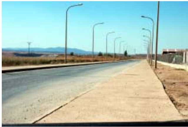
Ausencia de marcas viales
