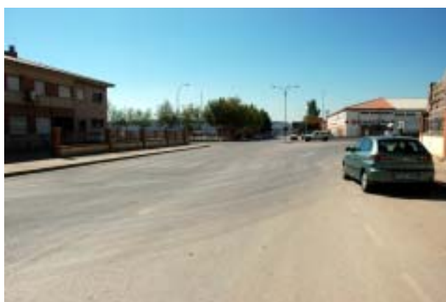
Paso de peatones sin señalizar
