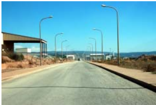
Ausencia de limitación de velocidad
