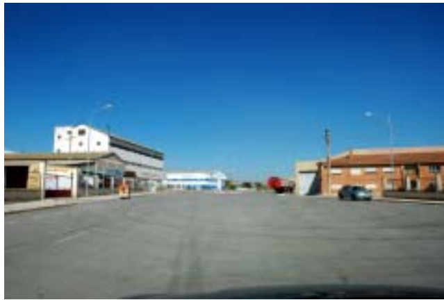
Ausencia limitación de velocidad
