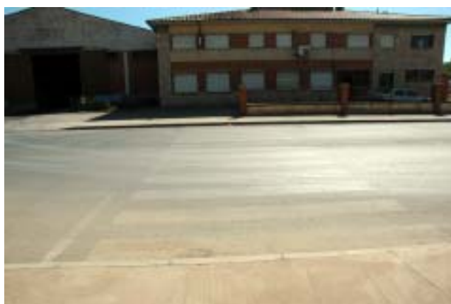
Paso de peatones sin señalizar
