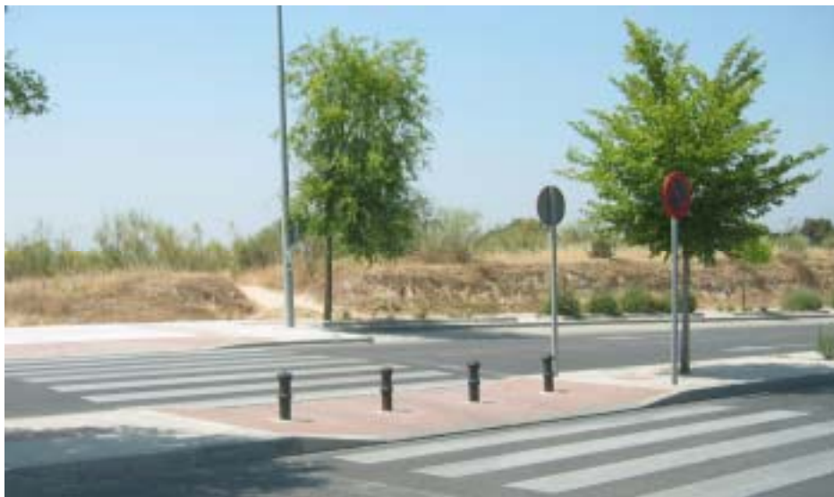
Refugio peatonal en mediana.
