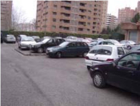
Ausencia de marcas viales.
