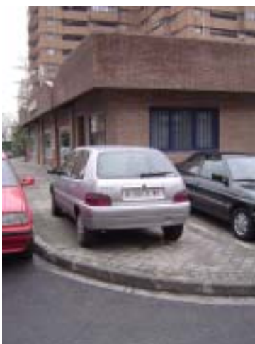
Acera invadida por vehículo estacionado.
