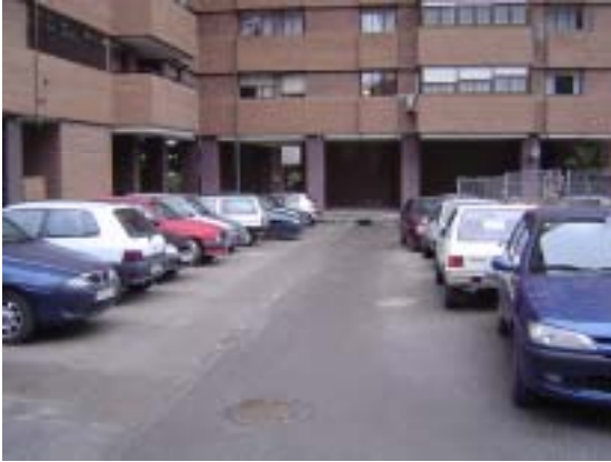
Ausencia de marcas viales.
