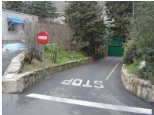
Salida de garaje privado con vegetación que dificulta la visibilidad.
