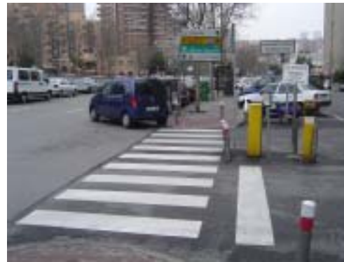
Visibilidad deficiente a la salida de la urbanización por vehículo estacionado en la esquina.
