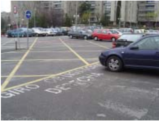
Marca vial reforzando señal vertical.
