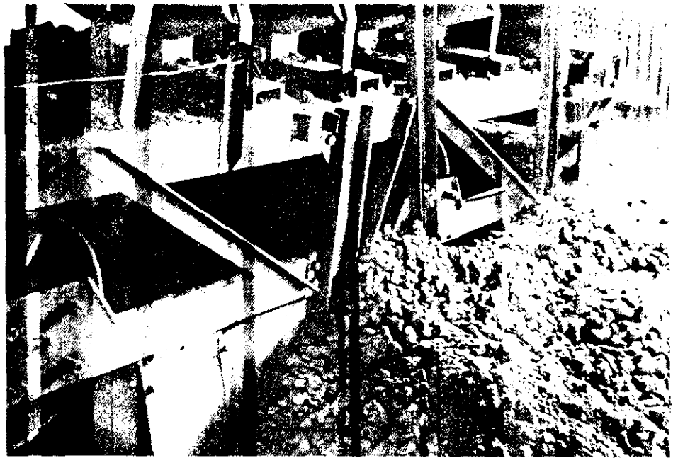
Zona de tránsito alrededor de tolva de alimentación. Falta de limpieza.
