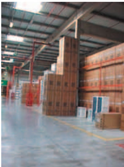
En la foto se observa cómo se respetan los límites, no llegando a la máxima altura de 7,60 m, establecida en la norma UNE-EN 23590.
