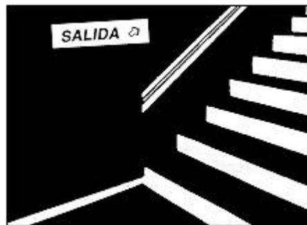
**Fig. 16: Recubrimiento de contrahuellas con pintura fotoluminiscente**
