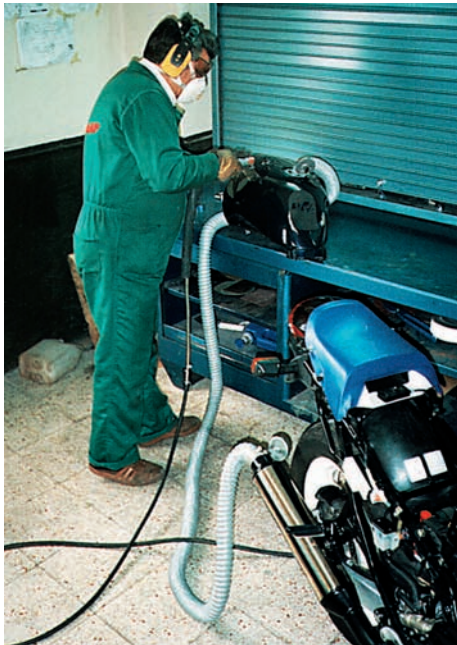
Desgasificado mediante gases de combustión
