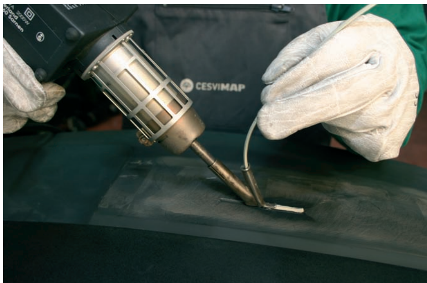
Soldadura con boquilla rápida
