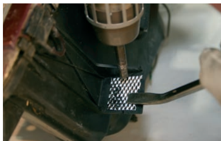
Refuerzo de la reparación
