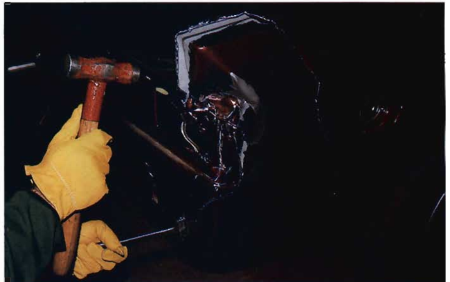
Corte de la zona dañada.
