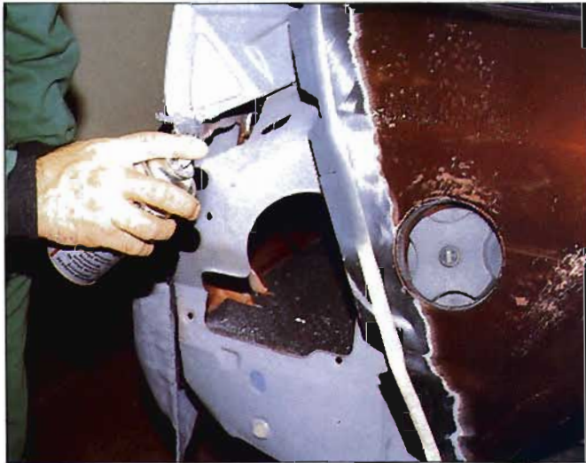
Protección con imprimación de cinc de la zona de solape.
