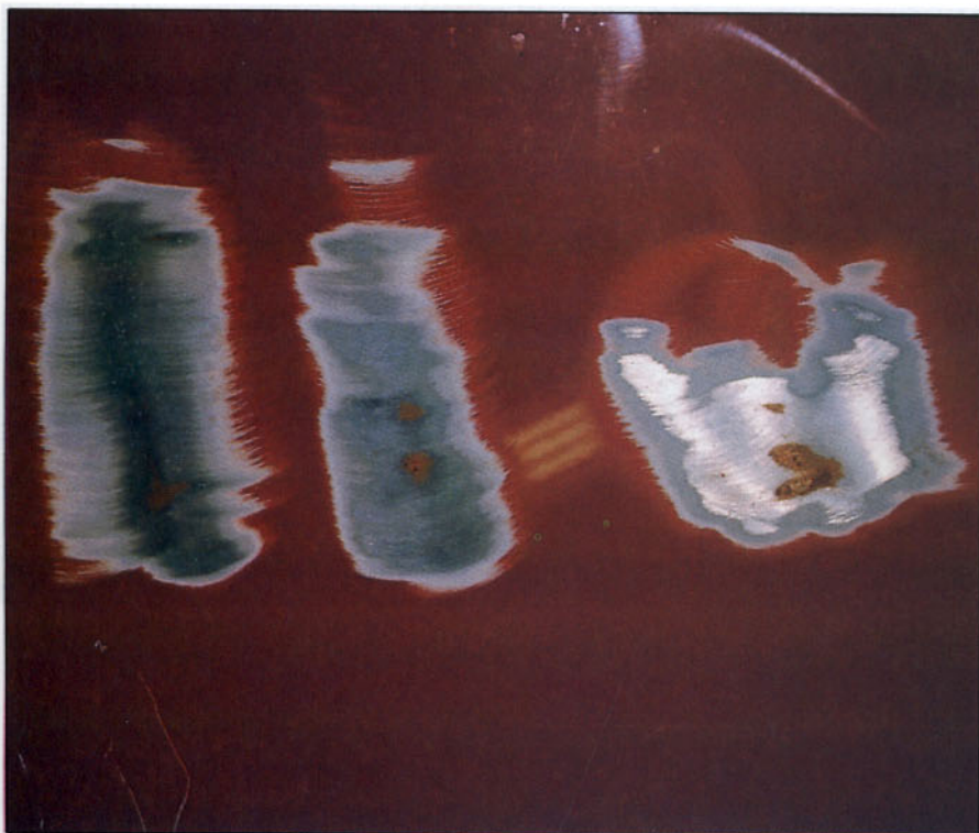
Aparición de óxido rojo donde se ha eliminado el cinc.
