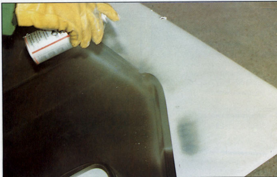
Aplicación de imprimación anticorrosiva de cinc.
