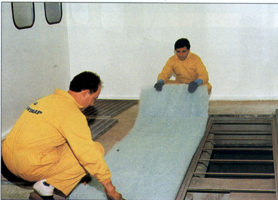
Sustitución de filtros de suelo.
