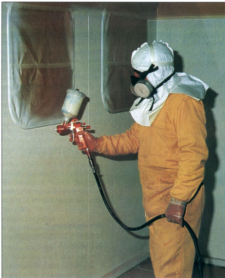
Pintado de paredes.
