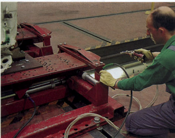
Aplicación de fuerzas correctoras con los cilindros hidráulicos
