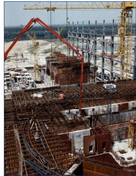
Obras de construcción de la central de Belene
