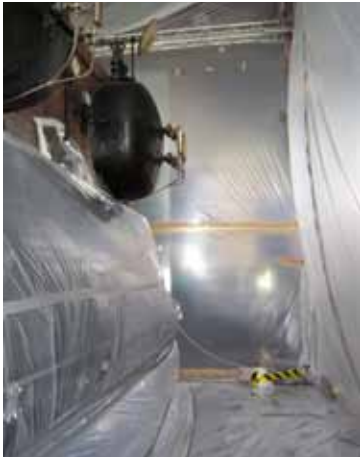
Figura 1. Confinamiento a presión negativa
