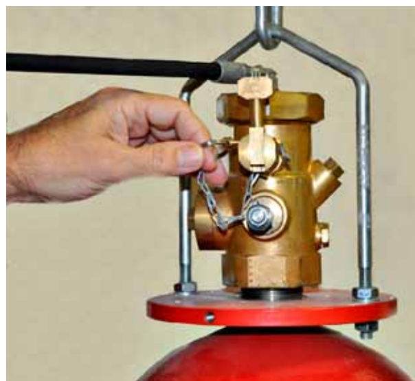
Figura 2. Mecanismo de disparo manual mecánico. Anilla de seguridad y palanca de disparo
