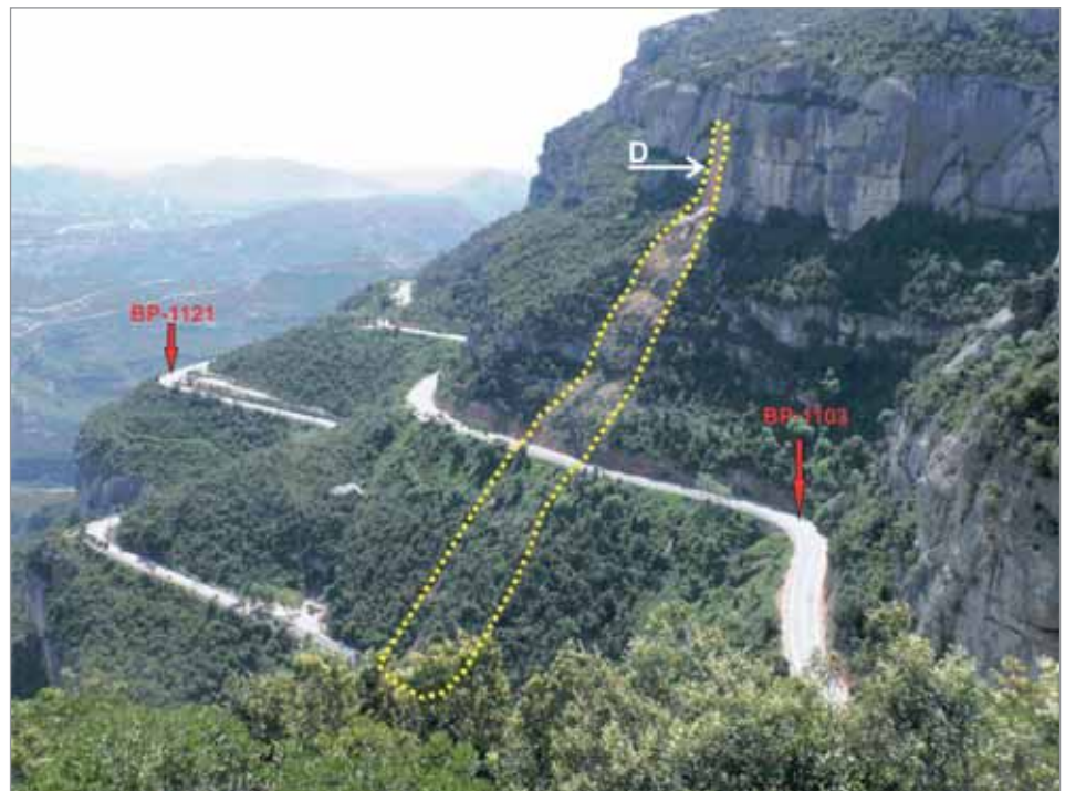
Figura 9. Tramos de las carreteras BP-1121 y BP-1103 que dan acceso al monasterio, con un trazado de gran sinuosidad que discurre a media ladera de la montaña. En la ladera se observan indicios de un desprendimiento en el escarpe y en la ladera inferior (D: zona de salida del desprendimiento; línea discontinua amarilla: límites de la zona afectada por el desprendimiento).
