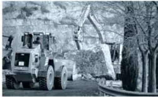
Las operaciones en estos días de post-desprendimiento refuerzan la carretera de acceso al monasterio.
