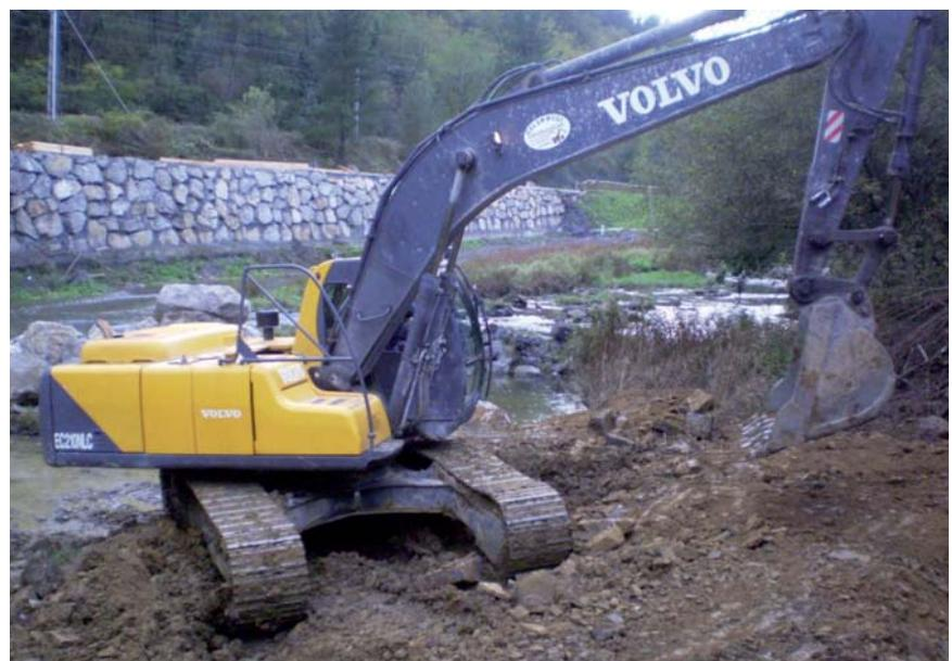
Reparación de un talud con retroexcavadora
