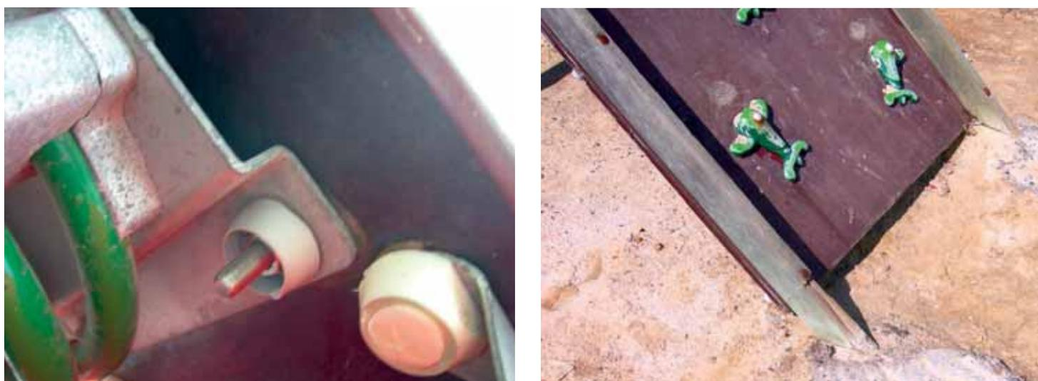
**Figura 7.** Diferentes peligros relacionados con la falta de mantenimiento: (a) tornillería sin protección y (b) afloramiento de la cimentación.
