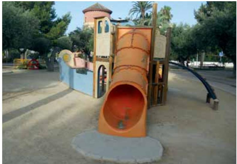
**Figura 4.** Área de juego inspeccionada sin superficie atenuante de impacto y en mal estado dentro del área de seguridad del equipamiento de juego.
