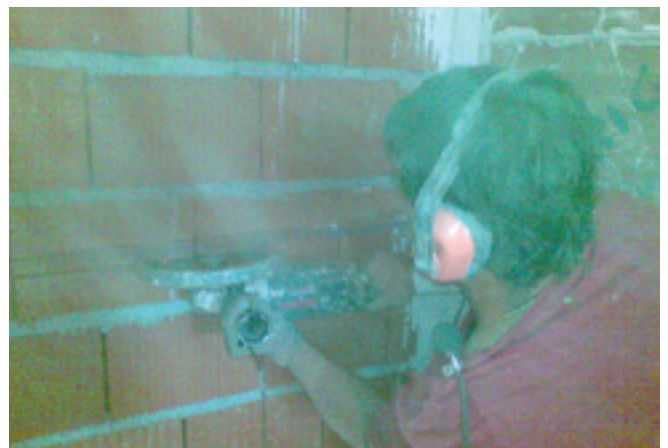
Figura 9. Trabajo realizado con amoladora grande.
