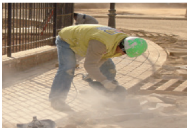
Figura 8. Trabajo realizado con amoladora grande.
