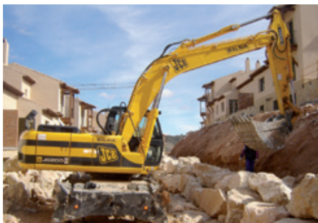
Figura 12. Trabajo realizado con maquinaria pesada.
