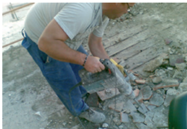
Figura 11. Trabajo realizado con martillo percutor.
