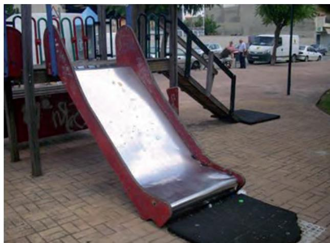
**Figura 4.** Área de juego inspeccionada sin superficie atenuante de impacto y en mal estado dentro del área de seguridad del equipamiento de juego.
