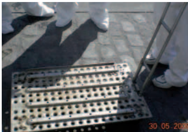
Limpeza de fondos marinos en el puerto de A Coruña
