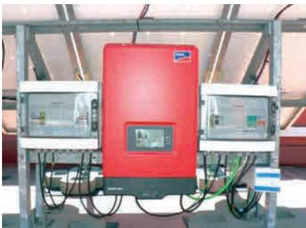
**Figura 22.** Caja de corriente continua, inversor y caja de corriente alterna. Fuente: elaboración propia.
