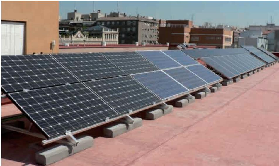
**Figura 1.** Instalación fotovoltaica de tipo general sobre cubierta plana de la Escuela Técnica Superior de Ingeniería y Diseño Industrial, Universidad Politécnica de Madrid. Fuente: elaboración propia.
