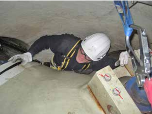
Figura 7. Acceso al interior del buje
