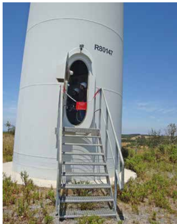
Figura 2. Acceso a la base de un aerogenerador.
