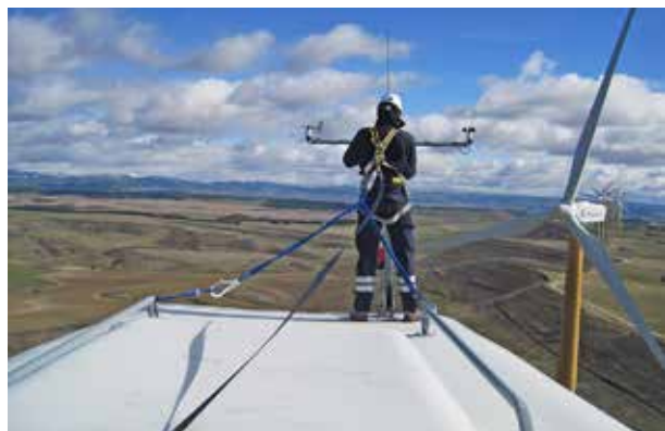
Figura 10. Trabajos en la parte superior de la góndola.
