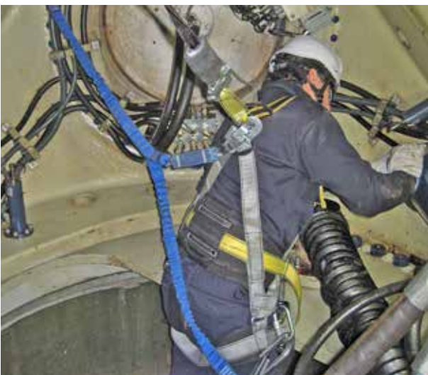
Figura 8. Trabajo en el interior del buje
