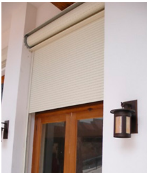
Esta persiana contra ciclones impediu a ruptura da janela do recinto.
