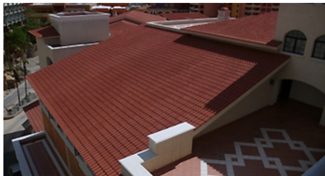
Falsas telhas (de concreto) sem danos.
