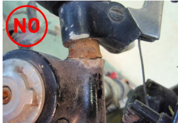
► Soldadura de semimanillar
