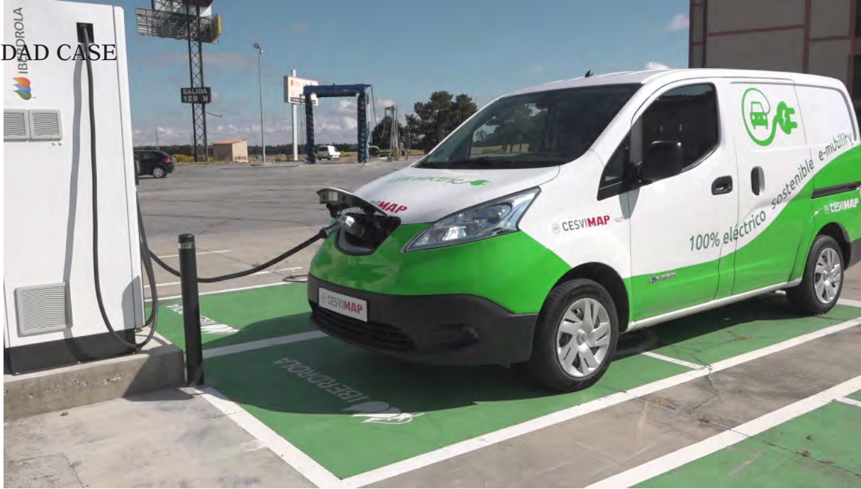
Carga a 50kW
