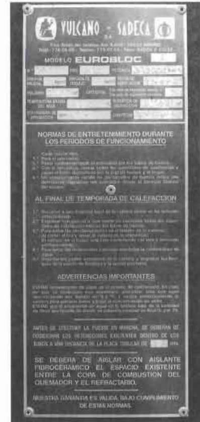
Foto 28. Ejemplo de placa de instrucciones para caldera eléctrica
