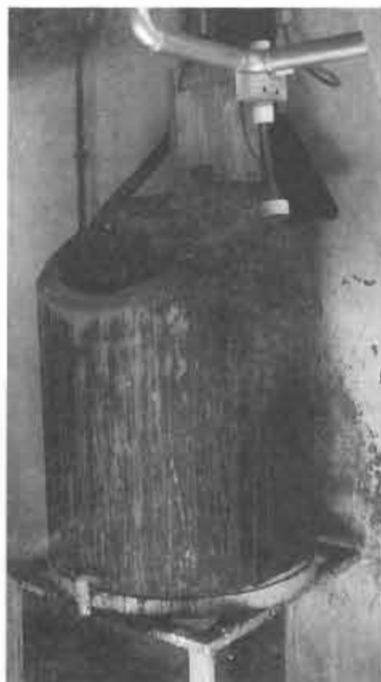
Foto 10. Recipiente para mezcla de productos (tratamiento de aguas).
