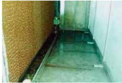
FIGURA 7. Interior de una central humidificadora.
