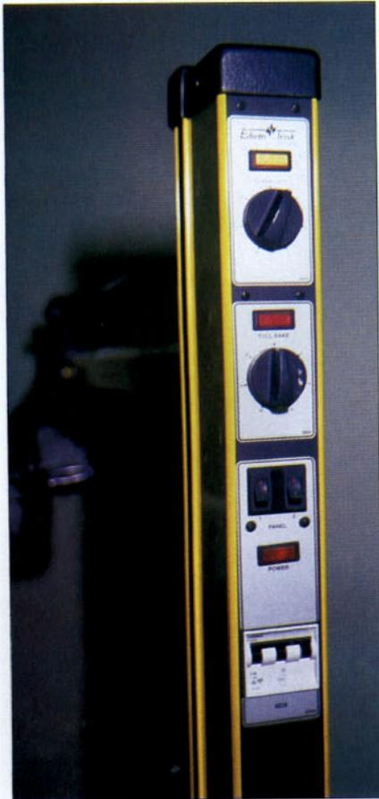
Cuadro eléctrico con interruptores de encendido-apagado y temporizadores.
