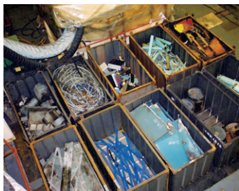
Segregación de materiales en el desmantelamiento (Fuente: Enresa)
