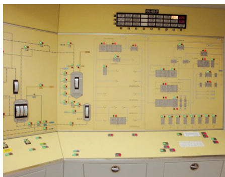
Sistema de control y vigilancia de efluentes gaseosos de una central PWR (Fuente: ANAV)
