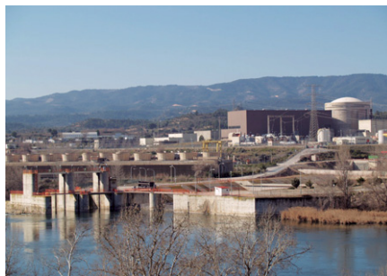
Toma del río y torres de tiro forzado. Central nuclear de Ascó (Fuente: ANAV)
