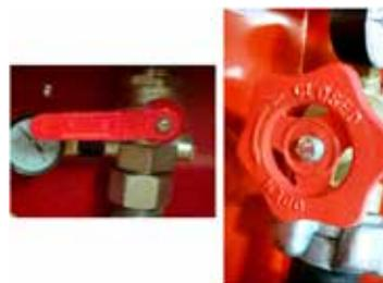
Diferentes modelos de válvulas de apertura del paso de agua desde la red
