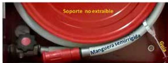
Soporte o carrete no extraíble. La manguera se desenrolla ayudada por un dispositivo orientador o "guía"
