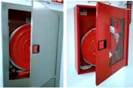
Puertas de BIE de apertura y cierre libre, girando sobre su eje vertical mediante bisagras
