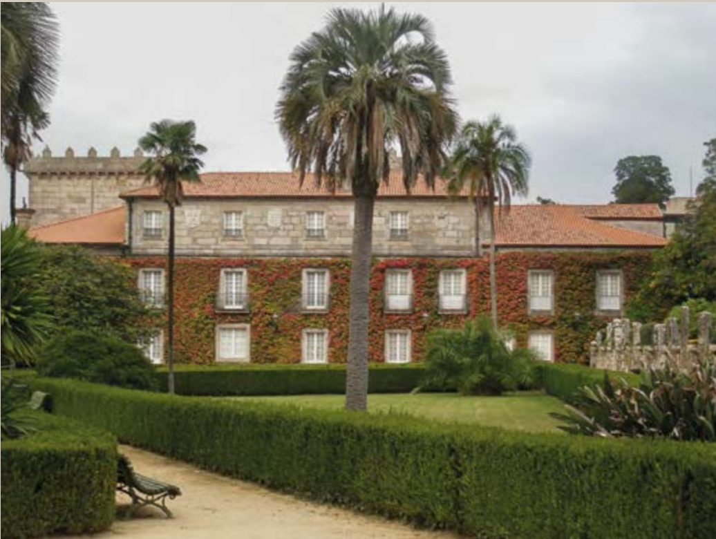
Fachada trasera del palacio de Castrelos con sus jardines.
