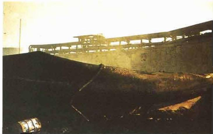
*Estado en que quedó el tanque n.º 9 producto de las llamas y combustible derramado del tanque n.º 8.*
