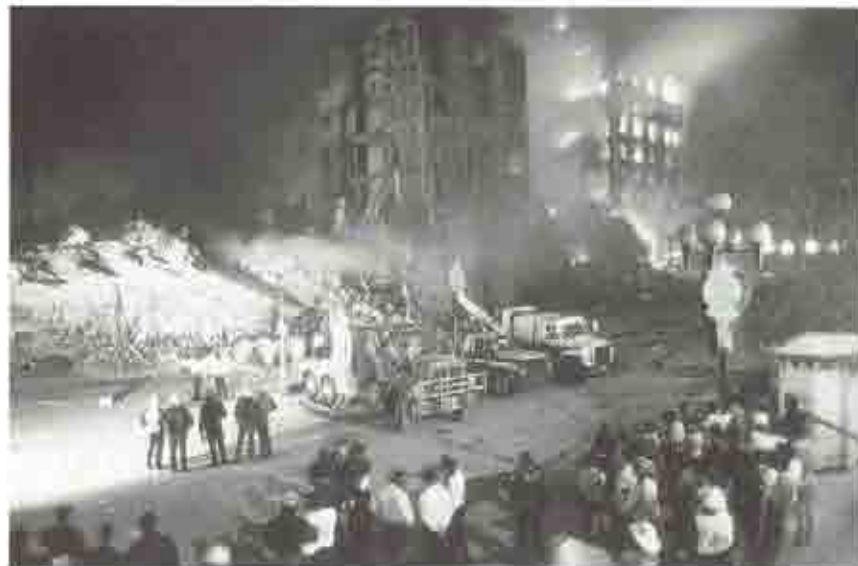
El control de la velocidad de propagación del incendio es un problema de múltiples parámetros que requiere un análisis total.
