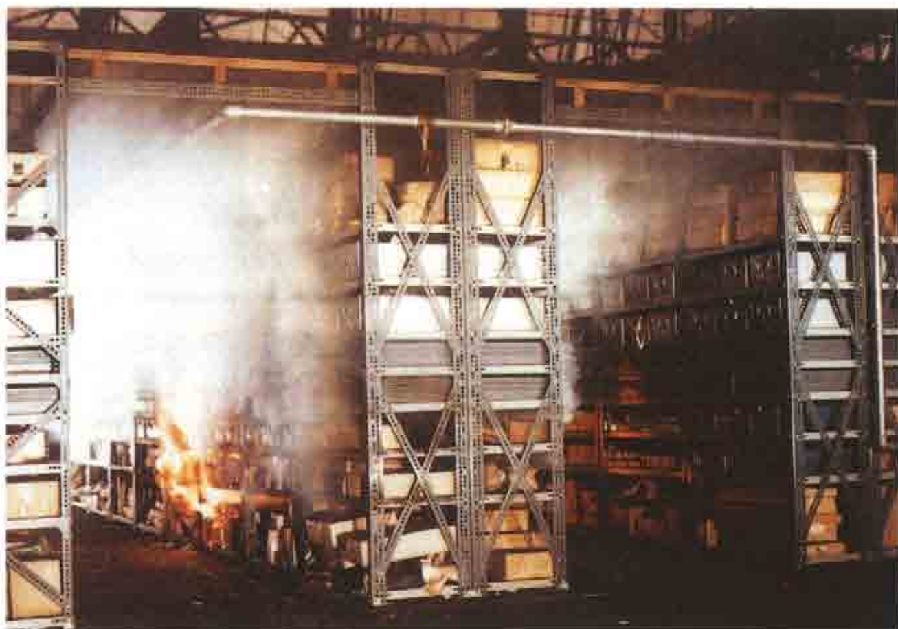
Figura 8. Los rociadores automáticos, empleados desde fechas tan tempranas como 1870, proporcionan una protección efectiva para la vida humana.
