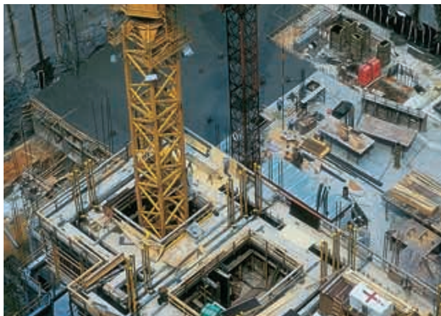
En las empresas de construcción hay que tener en cuenta necesariamente dos características: la temporalidad y la movilidad de dicha actividad.
