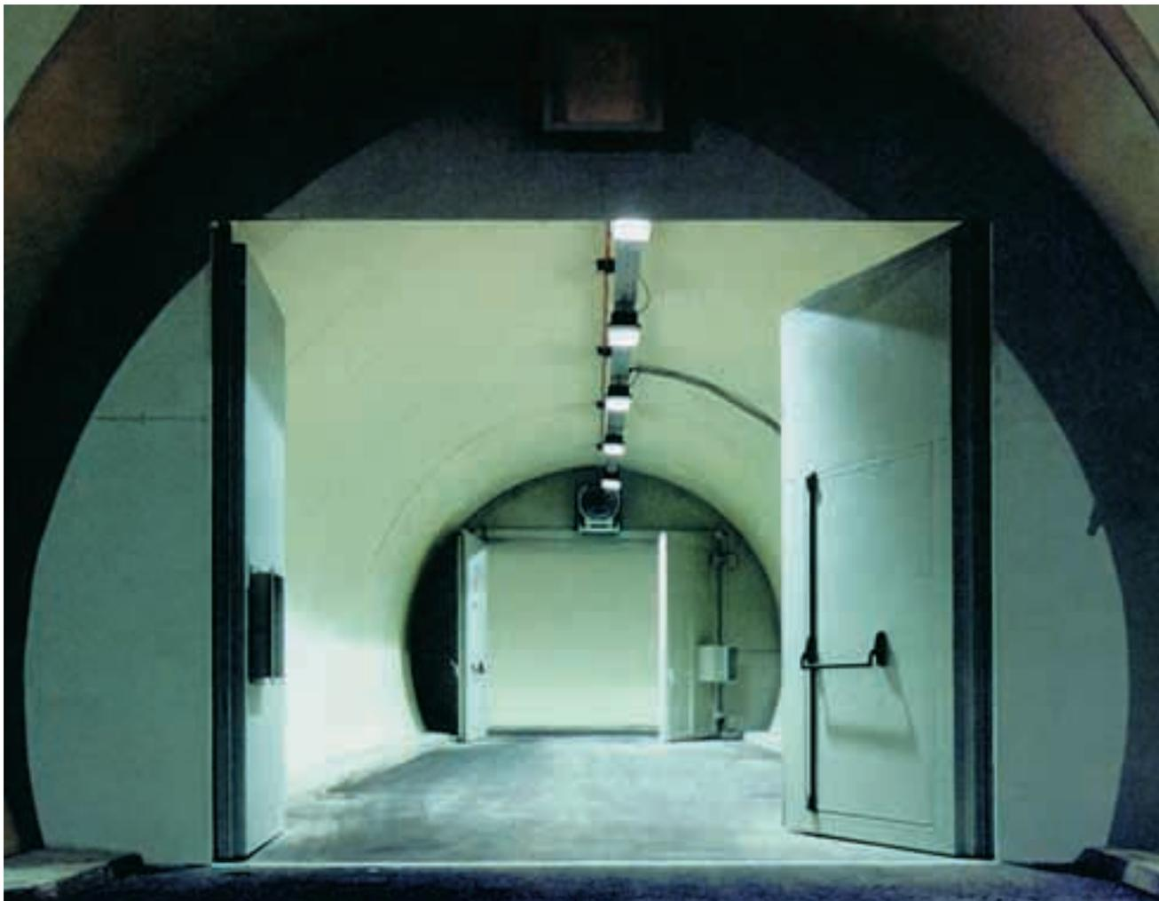
*By-pass: Comunicación permanente entre un tubo y otro del túnel que sirve como salida de socorro.*
