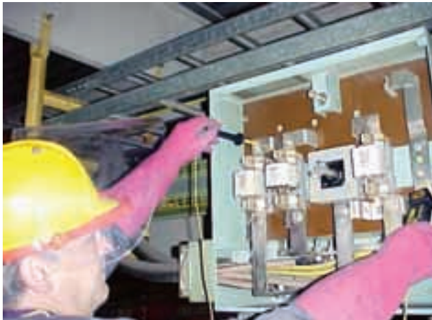
Figura 11. Comprobación de ausencia de tensión en la entrada.
