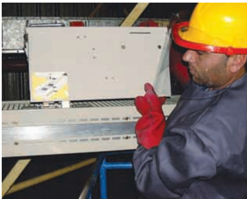
Figura 7. Operación de pinchado de una caja de derivación.
