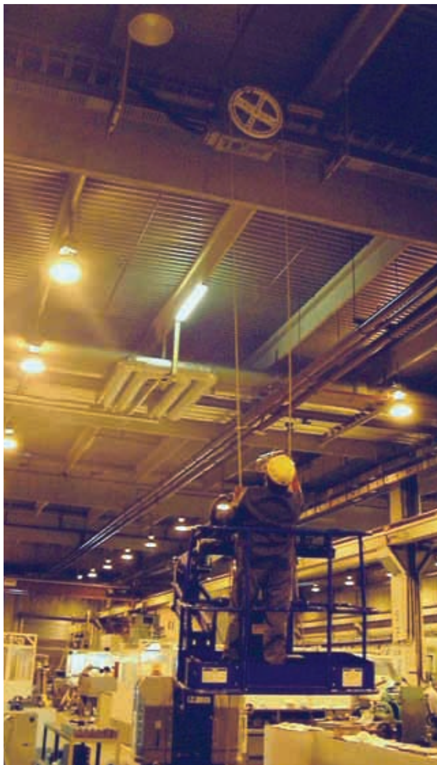
Figura. 10. Uso de un útil para abrir a distancia una caja de derivación.
