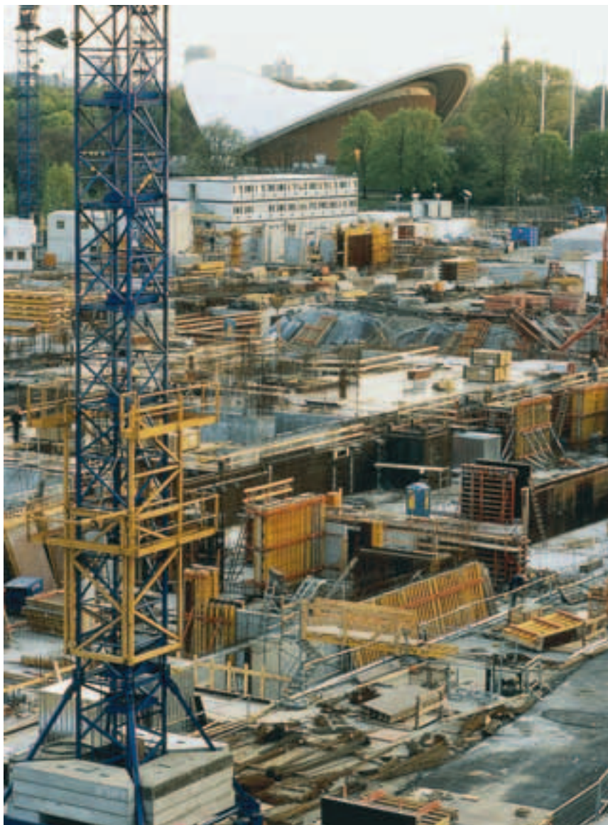
Los requisitos constructivos para garantizar las condiciones de seguridad de los lugares de trabajo pasan por tener una estabilidad estructural del edificio e instalaciones.
