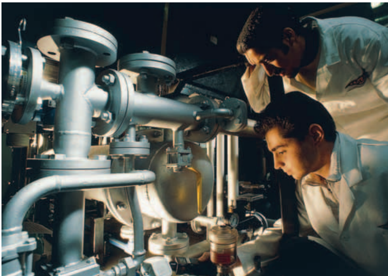
Medidas de prevención de instalaciones generales incorporadas en las mismas, bien sea en su fabricación, en su origen o in situ: recipientes a presión y conducciones.
