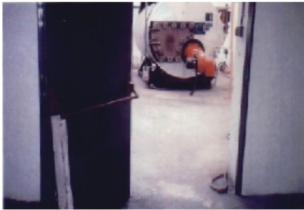
Hay que tener en cuenta que la característica de resistencia al fuego de una pared no tiene nada que ver con la probabilidad de resistir las presiones de una explosión.
