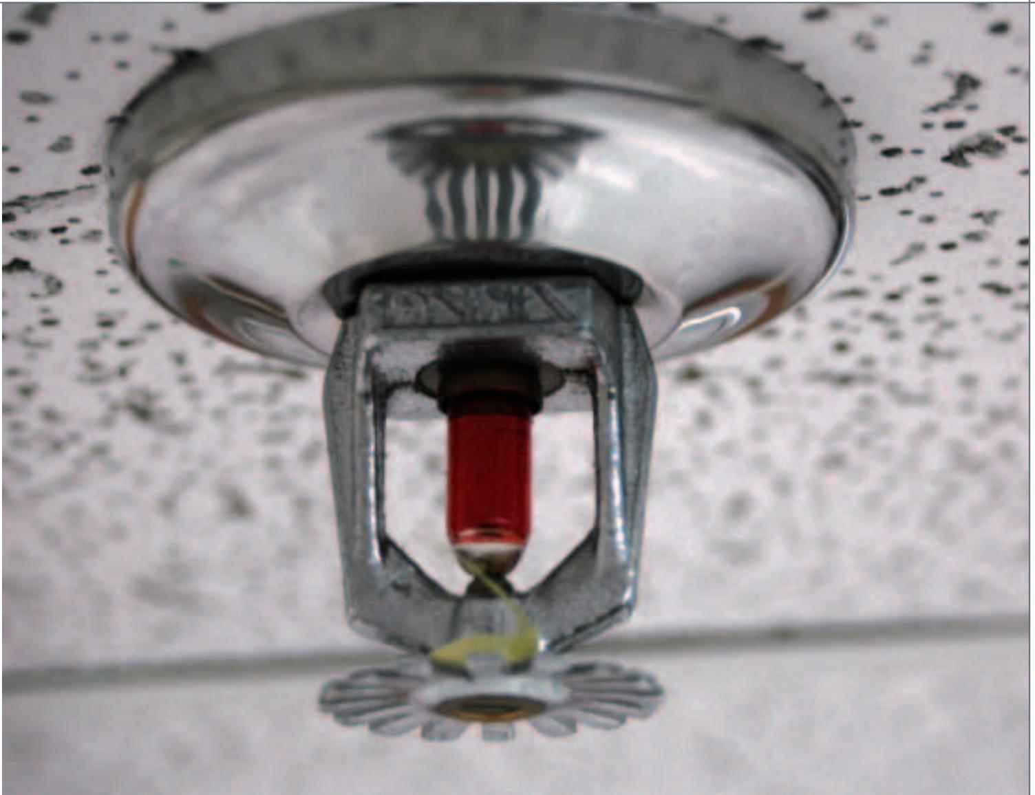
La comercialización de los rociadores automáticos ESFR, capaces de extinguir un fuego con una instalación sólo a nivel de techo, supuso un paso muy importante para la protección de grandes almacenamientos
