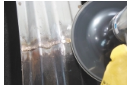
Desbastado del cordón de soldadura
