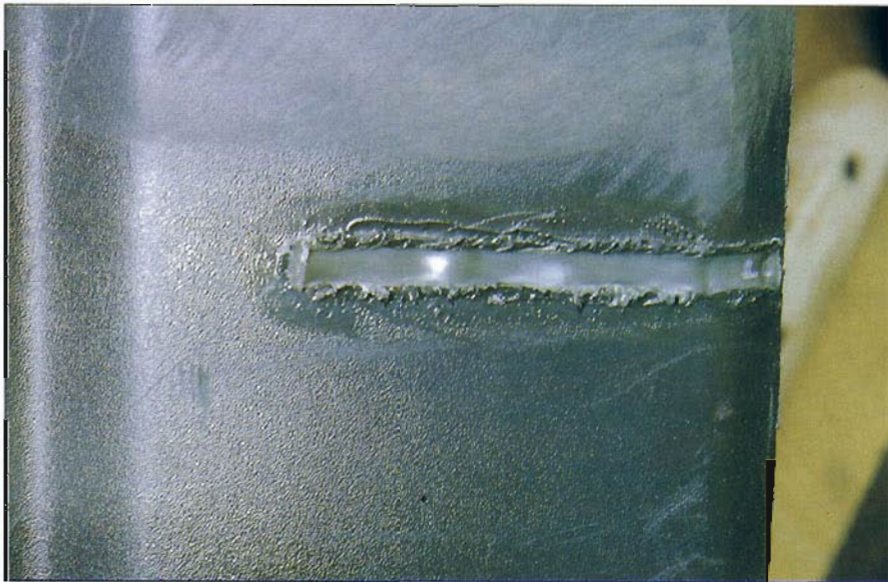
Soldadura realizada con alta temperatura.
