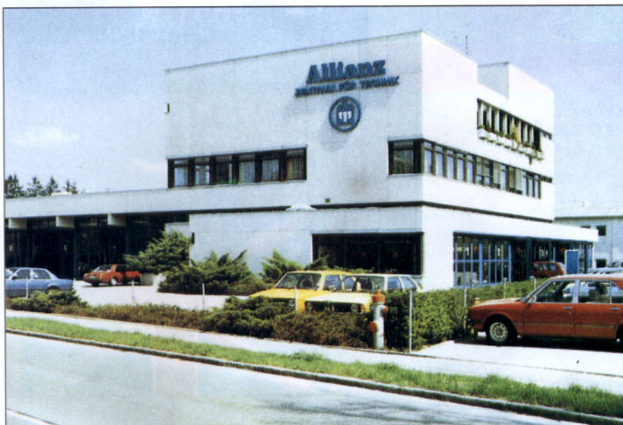
Centro AZT, sede del R.C.A.R. 1993.
